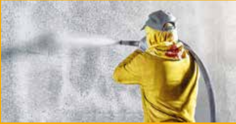
BETONSCHUTZ UND INSTANDHALTUNG
