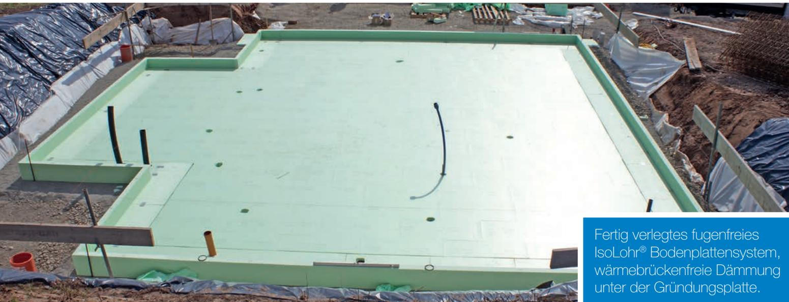
Fertig verlegtes fugenfreies IsoLohr® Bodenplattensystem, wärmebrückenfreie Dämmung unter der Gründungsplatte.
