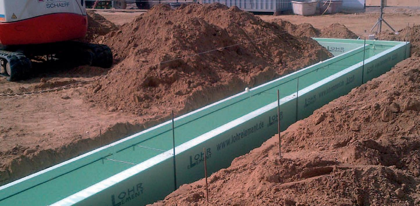
**TIPP** Für die Herstellung von Fundamentecken bietet LohrElement passende Ecken als Systemkomponente an (siehe Seite 64).
